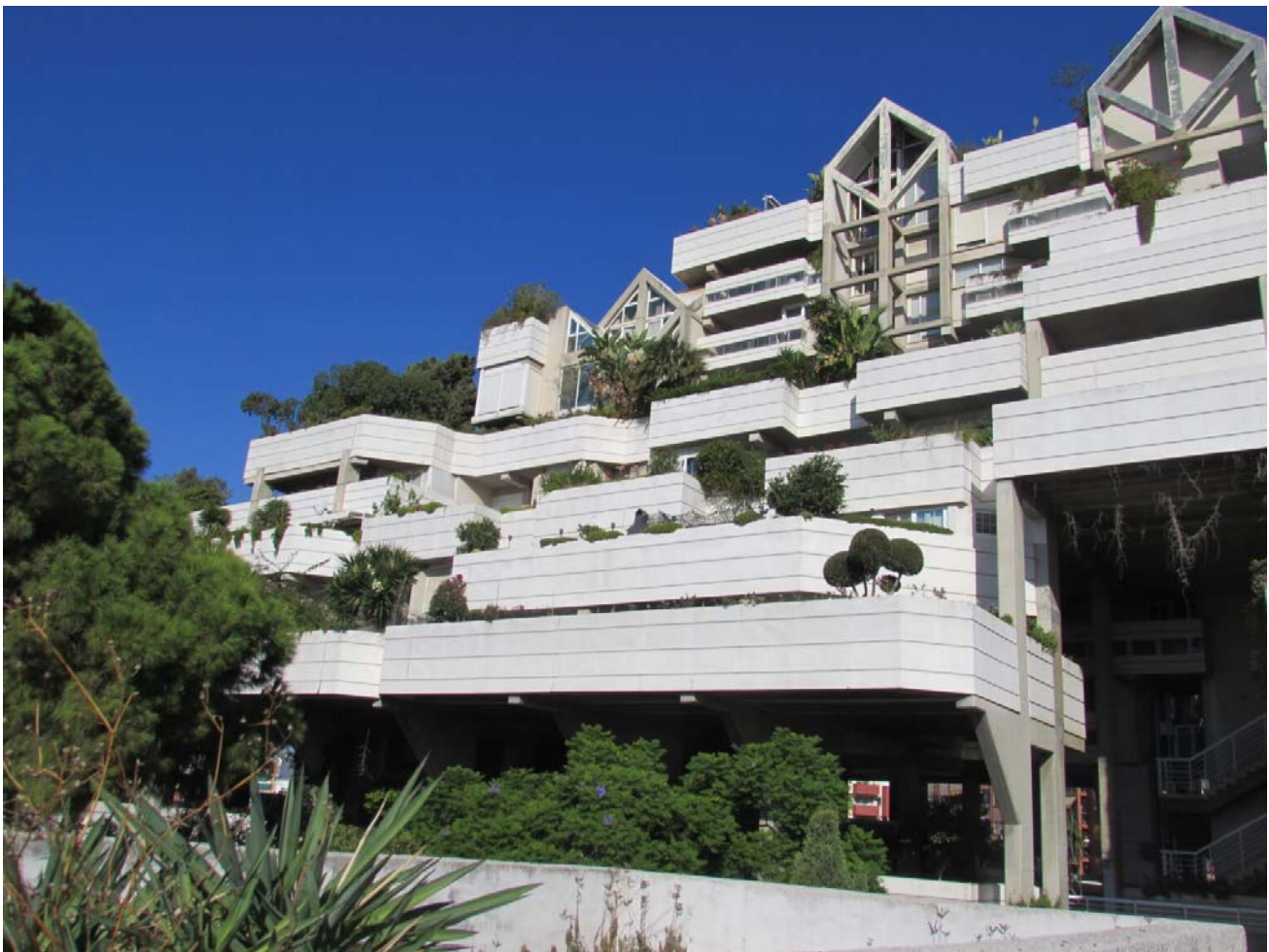
Der 21.000 m 2 große Wohnbau Espai Verd, entworfen von Antonio Cortés, integriert die Natur als wesentlichen Bestandteil. Die Struktur ist vorgefertigt, auf einem 6 x 6 Gitter angeordnet, gestuft und über dem städtischen Gitter um 45° gedreht, um so viel Sonnenlicht wie möglich einzufangen. © Pressebüro Legat
